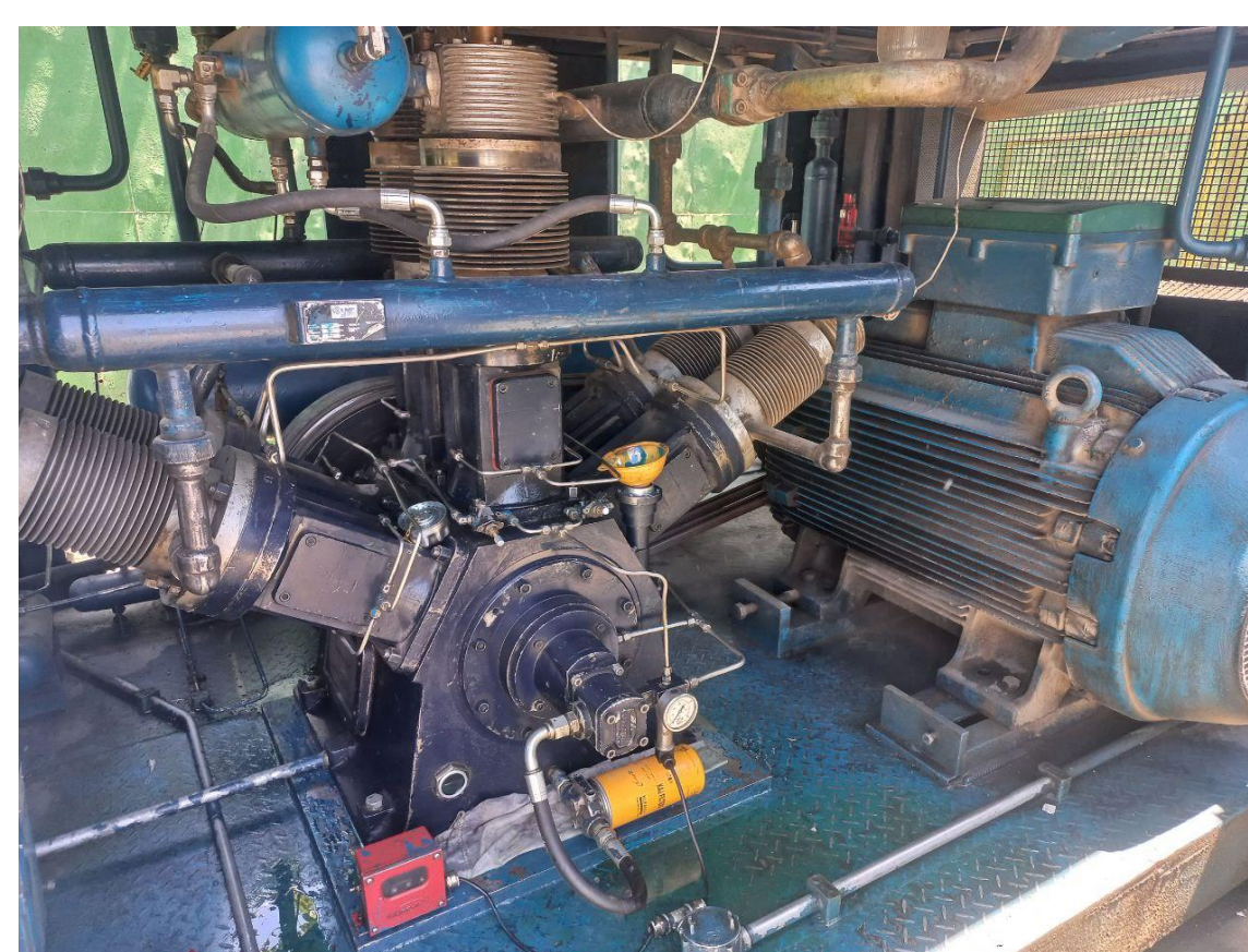
شکل ۲ کمپرسور LMF استفاده شده در جایگاههای CNG
