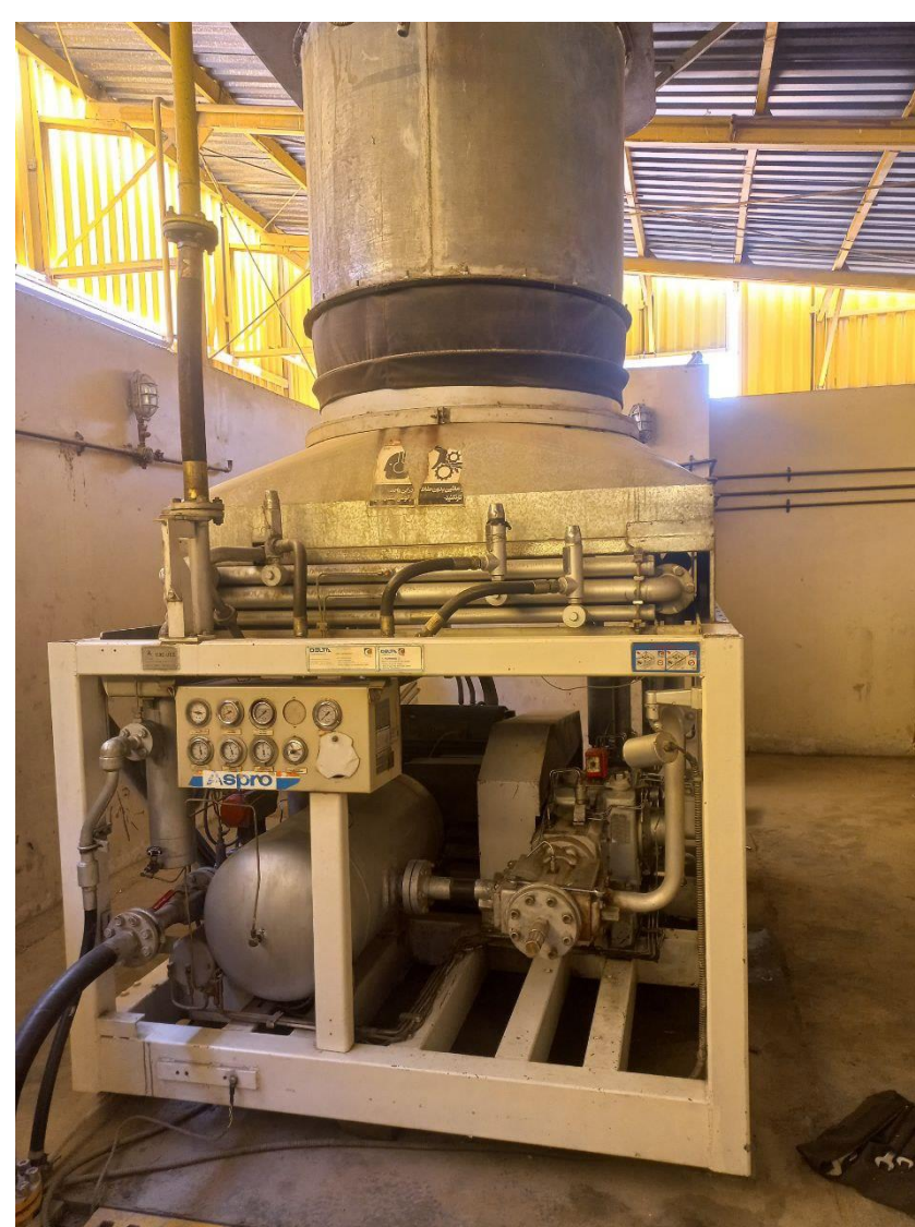
شکل ۲ کمپرسور LMF استفاده شده در جایگاههای CNG
